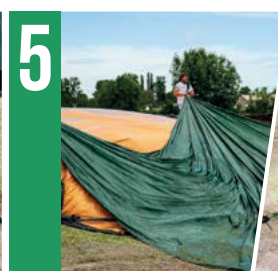
5 Mise en place des 2 bâches
